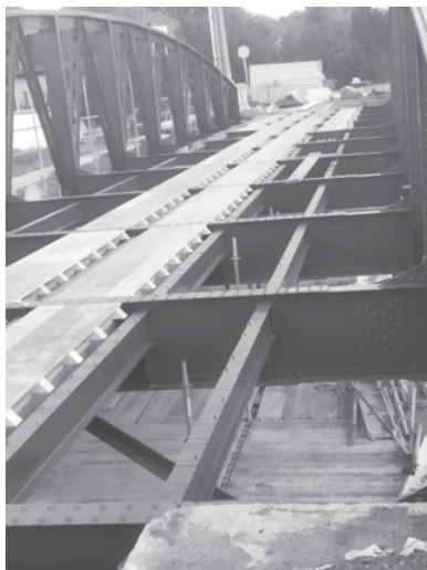
Z původního mostu zbyla jen základní konstrukce
