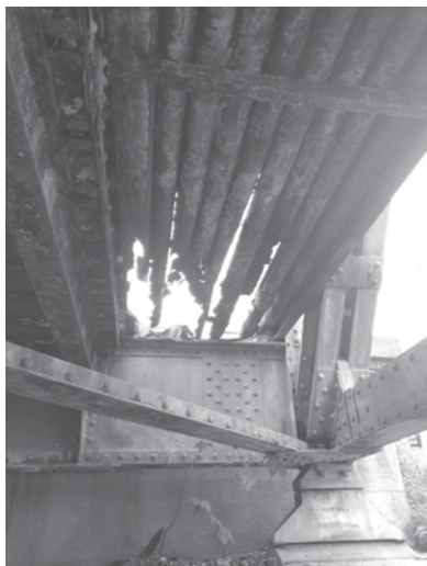
Stav starého mostu na Hlucholazské ulici
