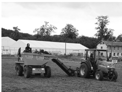
Zahájení rekonstrukce fotbalového hřiště
