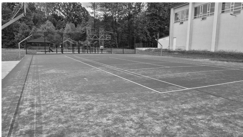
Nový povrch na víceúčelovém hřišti za ZŠ Mikulovice
